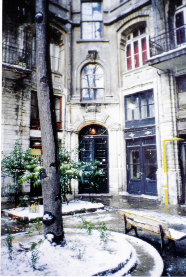
Arif Paşa Apartmanı, Elmadağ.
